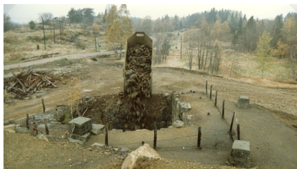
Fyllning av gruvschakt vid Bersbo. Foto Bertil Göransson.
