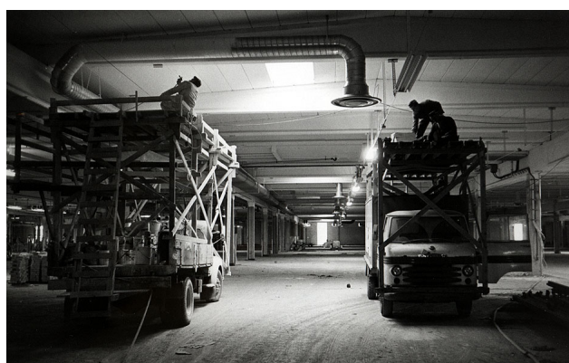
De ovanliga byggnadsställningarna för invändiga takarbeten. Foto Facits arkiv
