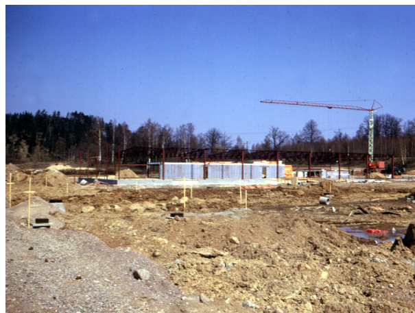
Byggnation av industrifastighet på området Fågelsången 1974. Foto. A. Agerbo
