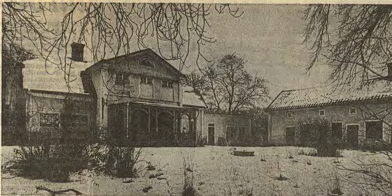
Planerna för upprustning av Kallerstad har varit många. Nu har den senaste — och troligen den sista — spruckit. Inget annat än rivning återstår
