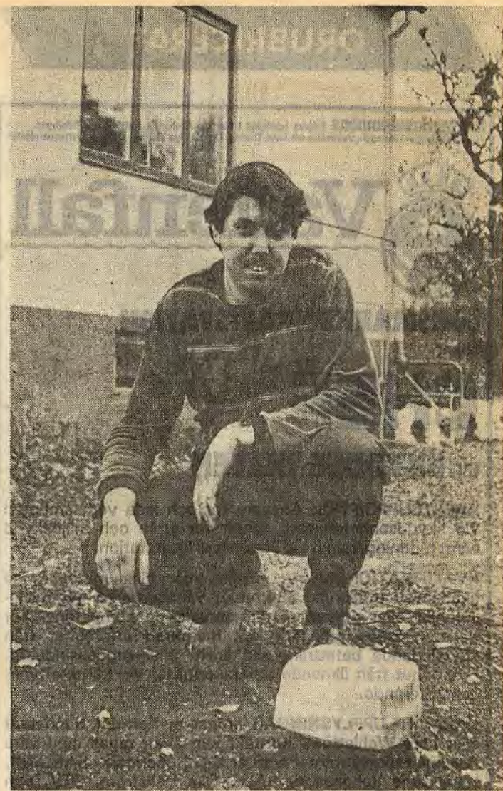
Ett litet plastlock ett par meter från huset är det enda som utvändigt visar att Bengt-Erik Fredriksson värmer upp hela sitt stora hus med värme från grundvatten. Under locket finns en drygt 100 m djup brunn
