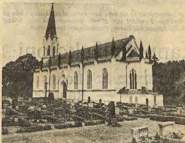
Renoveringen av Gärdserums kyrka är nu i det närmaste klar. Över 600 000 kr har det kostat att bli ge tornet en nödvändig översyn
