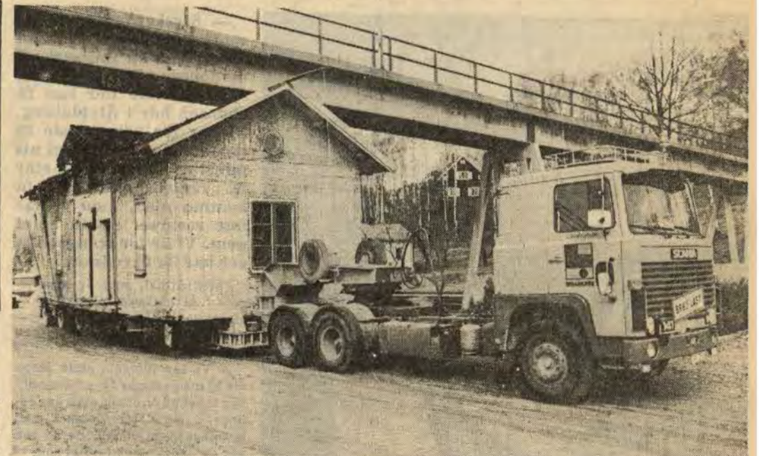
Efter 124 år på platsen flyttades Sveriges äldsta banvaktsstuga, Tröjan, till Järnvägarnas museiförenings uppställningsplats i Linköping. Till stor förargelse för järnvägsvänner och kulturvårdare i Åtvid. Det var nätt om utrymmet, bara 10 cm, när man tog sig under gangbron i Åtvidaberg
