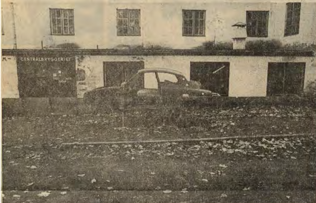
Centralbryggeriet med kvarglömt, långtidsparkerat fordon. En liten björk växer i lugn och ro på taket intill skorstenen
