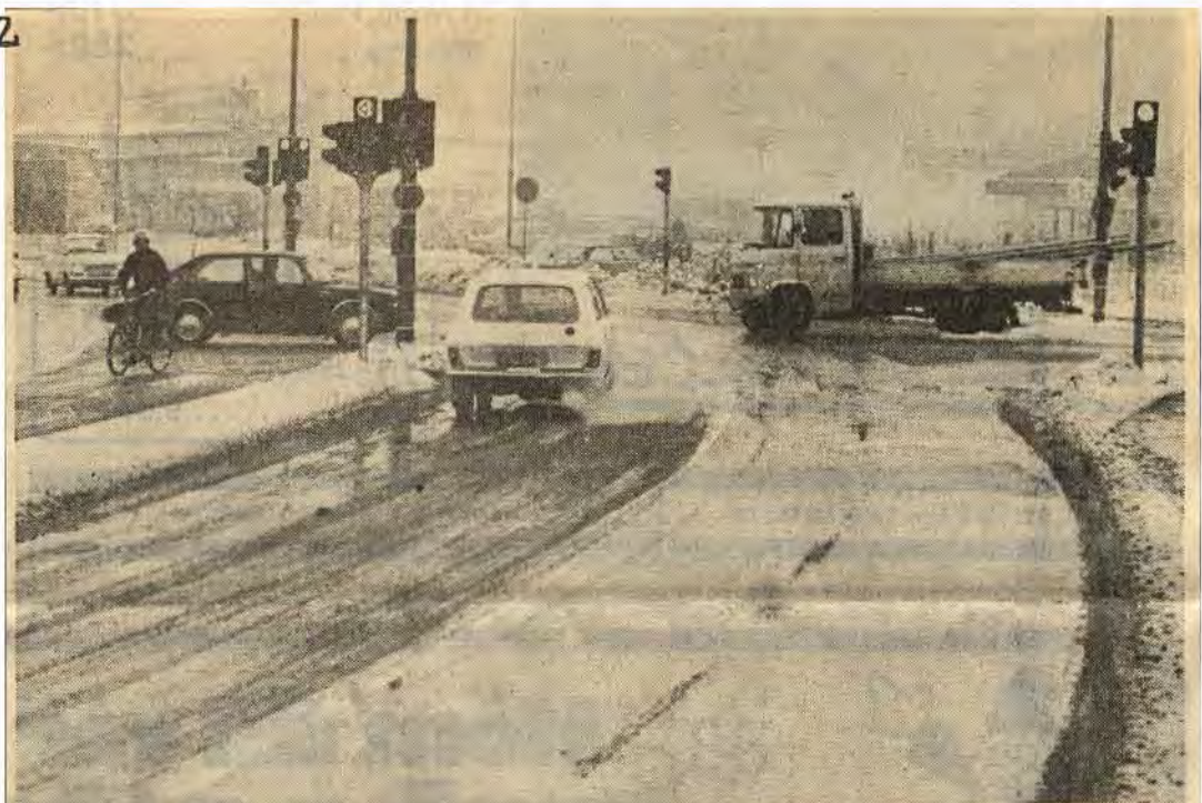
I veckan har det varit premiär i Åtvidaberg. Samhället har fått sina allra första trafiksignaler om man undantar det tillfälliga signalsystemet vid Facits Örsättersfabrik
