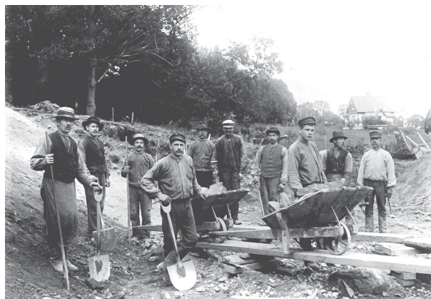
Kanalen till Åtvidabergs kraftstation grävs 1905. Foto Johan E. Thorin.
