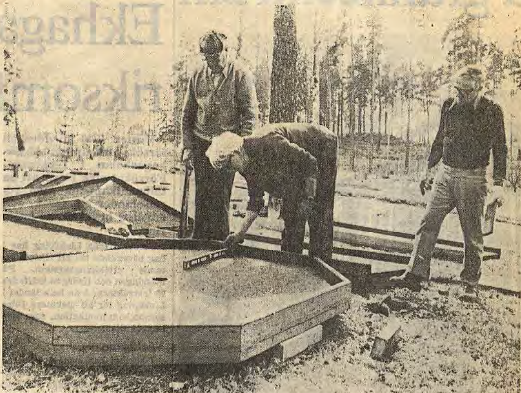
Det är noga att ringen inte sluttar åt något håll. Här är det Bobby Nilsson, Olle Nelly och Evert Svensson som kontrollerar den saken
