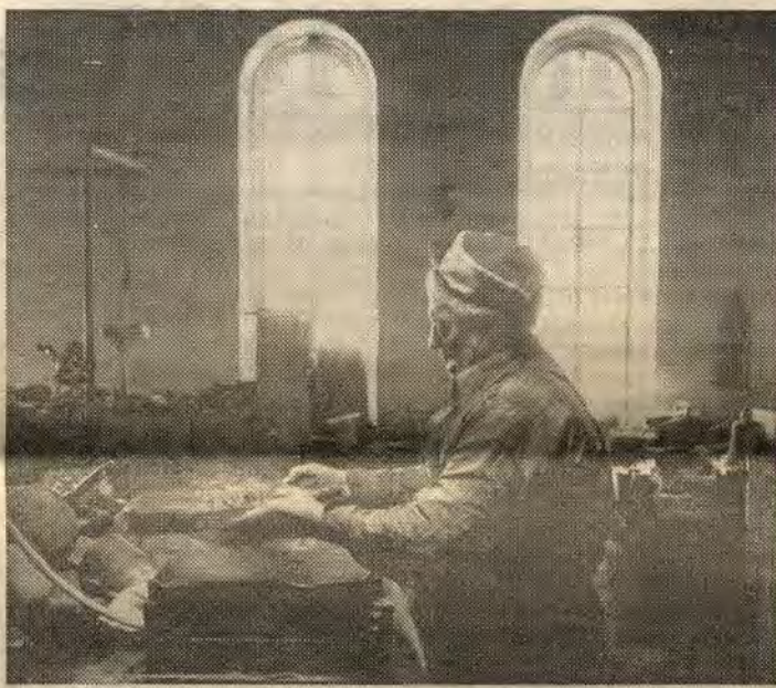
Sedan formarna med rödsand och modeller fått torka över natten i 350 graders värme plockas modellerna bort och häligheterna rengörs
