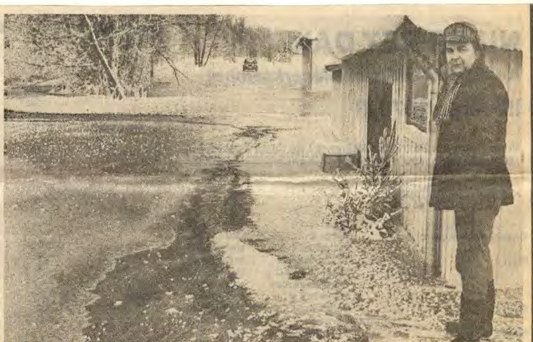
EN METER IS täcker fotbollsplanen i Falerum. Inte nog med det. I omklädningsrummen står vatten ett par decimeter högt och byggnaden är troligtvis totalförstörd. Det är en översvämning av Storån som orsakat skadorna. Klubbens ordförande Åke Bergström (bilden) karakteriserar det hela som en katastrof för föreningen
