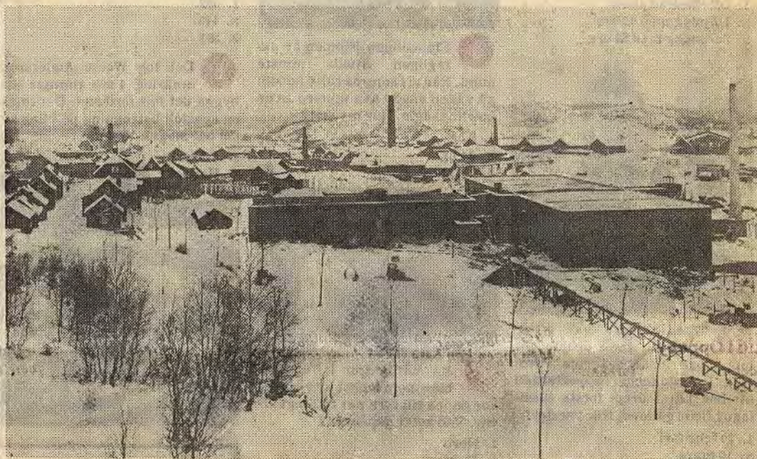
Vy över Åtvidaberg från 1904. Till vänster ses Verksgratan med sina 1700-talshus och som nu håller på att rustas upp. I gatans förlängning står brandstationen som numera är rivet. I förgrunden håller Åtvidabergs snickerifabrik på att uppföra den nya snickerifabriken. Kullarna i bakgrunden är Långbrottsområdet som i dag är i det närmaste helt bebyggt
