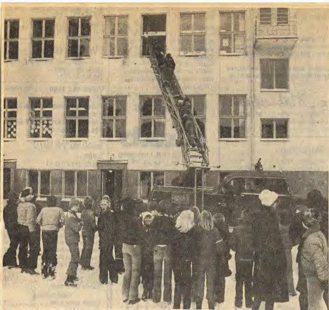
På mindre än två minuter hade man utrymt nästan hela Centralskolan med dess ca 600 elever och lärare. Återstod gjorde då klass 3A. För den klassen fanns endast fönstervägen. Utanför fönstret väntade brandförsvaret med stora brandstegen. Bra och nyttig övning
