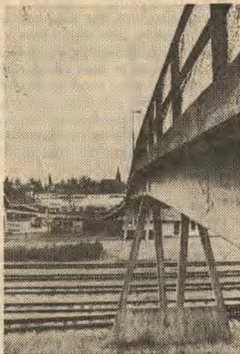
Värmeslingorna i gångbron brantaste del ska bytas ut inför vintern
