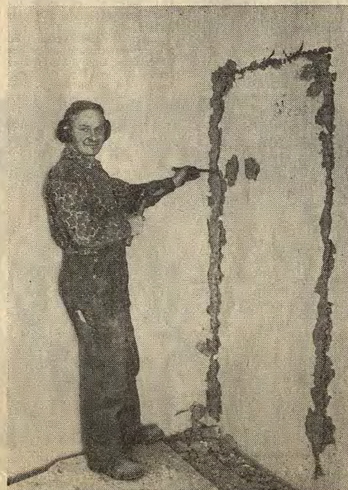
Nu bultas det, hamras och borras i ett par av lägenheterna i Eksätter. Tomma tvåor som görs om till större och mindre lägenheter. För sådan är efterfrågan. På bilden ses Roland Andersson från Östgöta byggkonsult i full färd med att ta upp en dörr i en av betongväggarna
