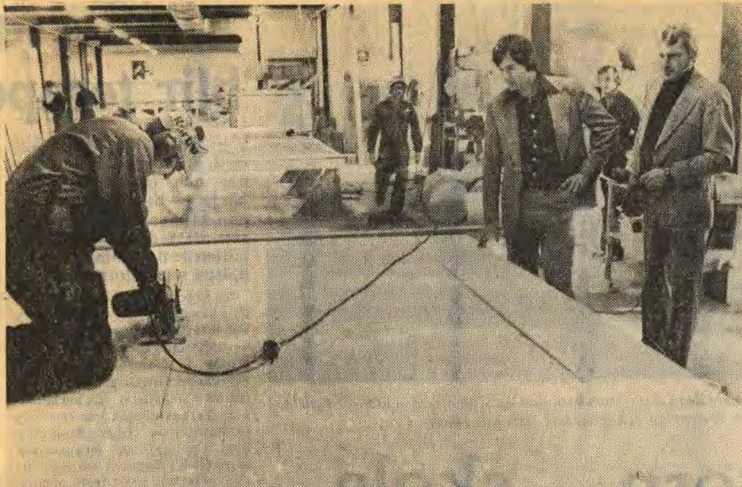
Byggnadsingenjör Håkan Johansson och försäljningschef Anders Söderqvist betraktar hur byggnads-snickare Arne Svensson gör en ursågning för ett fönster i den nya helformatsväggen
