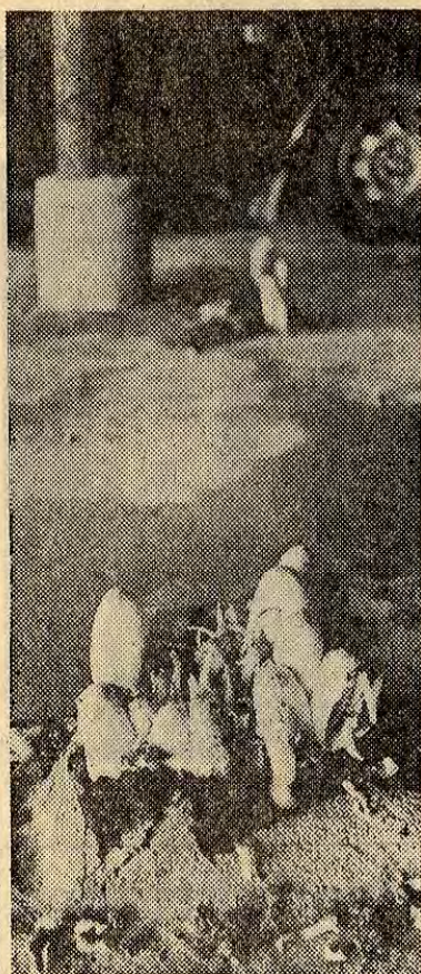
Hela buketter av fjällig bläcksvamp har trängt upp genom det 4—5 cm tjocka asfaltgolvet i reningsverkets utegarage i Åtvidaberg
