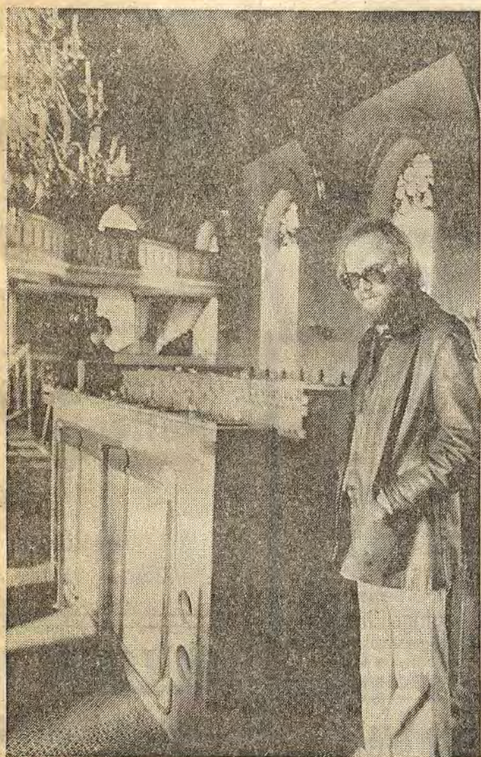
Atvids nya kyrka ser just nu ut som en verkstad. De danska orgelbyggarna har börjat installationen av den ombyggda orgeln. På bilden vid ett par väderlådor musikdirektör Ingemar Ericsson
