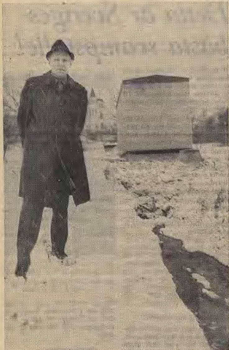
Nils Önnebo, Hägerstad, Hannäs, vid byggnaden med det nya reningsverket
