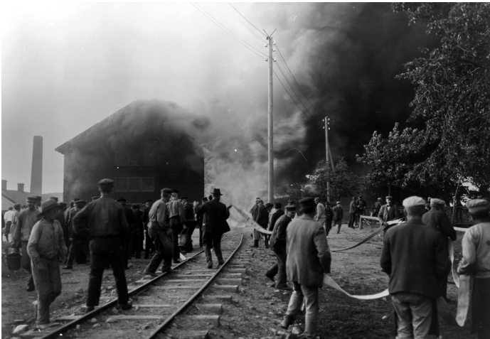
Branden startar i snickerifabriken.
